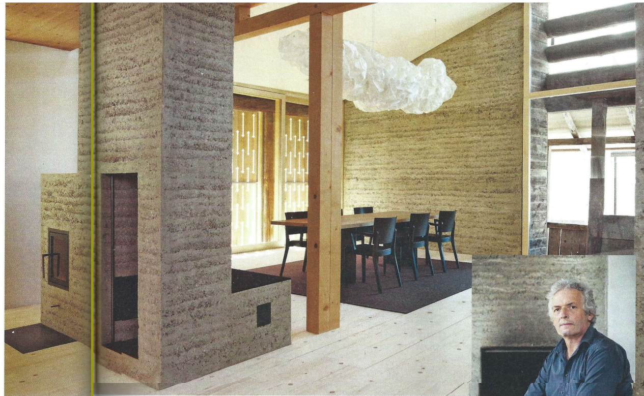
STALL PLAZZA PINTGIA: Tragende Stampflehmwände mit integriertem Speicherofen sorgen für ein angenehmes Raumklima. Architektur: Gujan Pally Architekten
