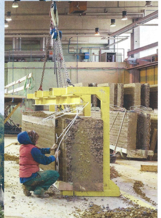
VERSCHIEDENE BAUWEISEN: Der Lehm für das Haus von Martin Rauch wurde vor Ort gestampft. Da das im urbanen Raum oft nicht möglich ist, fertigt seine Firma Stampflehmteile auch in der Halle vor (o.)
